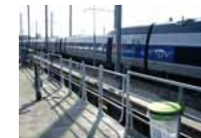
Protections et portillons ; mise en conformité des accès pour les personnes à mobilité réduite
