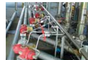
Réalisation de tuyauterie hydraulique pour l'alimentation des vannes Sepam.
