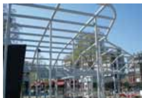
Fabrication et pose d'une verrière à structure métallique pour kiosques commerciaux
