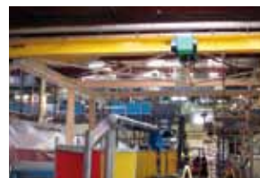
Fabrication et installation d'une charpente et d'un pont roulant
