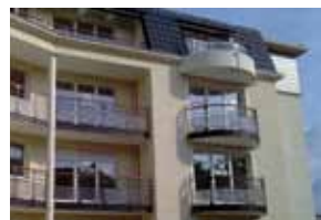
Fabrication et pose de garde-corps droits et courbes pour une résidence de 41 logements
